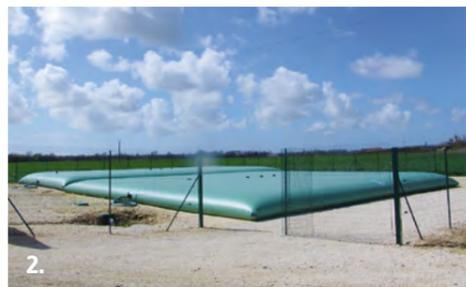
2. Пример установки резервуара для подачи воды.
