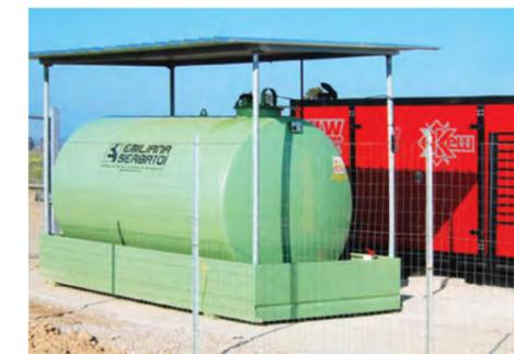
Резервуары изготовлены в соответствии с М.Д. от 28 апреля 2005 и М.Д. от 22 октября 2007. Предназначены для хранения ДТ и питания генераторных установок и систем отопления.
